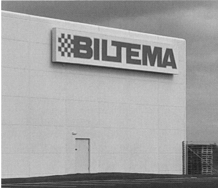
Bild 1. Självrengörande fasad av titandioxid \text{TiO}_2 . Hertzell (2013).
