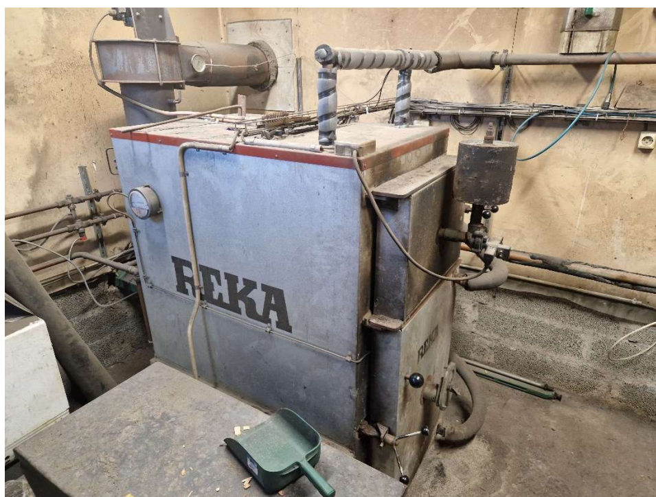
Figur 2.3 Visar hur pannan HKRST-60 ser där figuren visar pannan, askhållare, rör för rökgaser och luckan in till förbrännaren.
