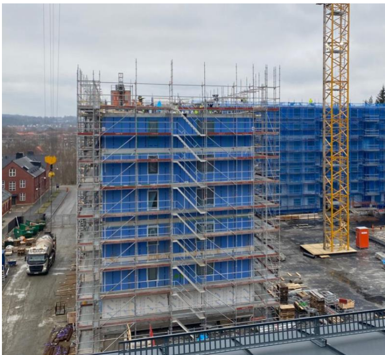
Figur 4. Ställning vid nyproduktion av bostadshus.
