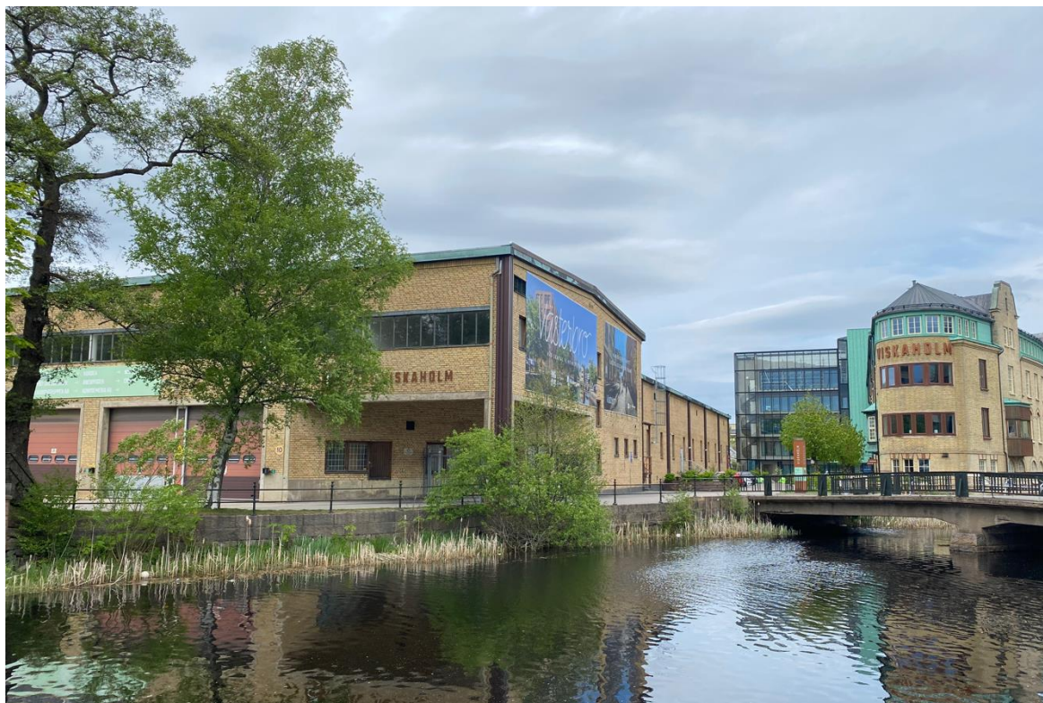
Figur 3. Lagerbyggnaden till vänster och den renoverade kontorsbyggnaden till höger.
