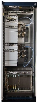
Figur 8 MINI-LINK LH (Telefonaktiebolaget LM Ericsson 2019)
