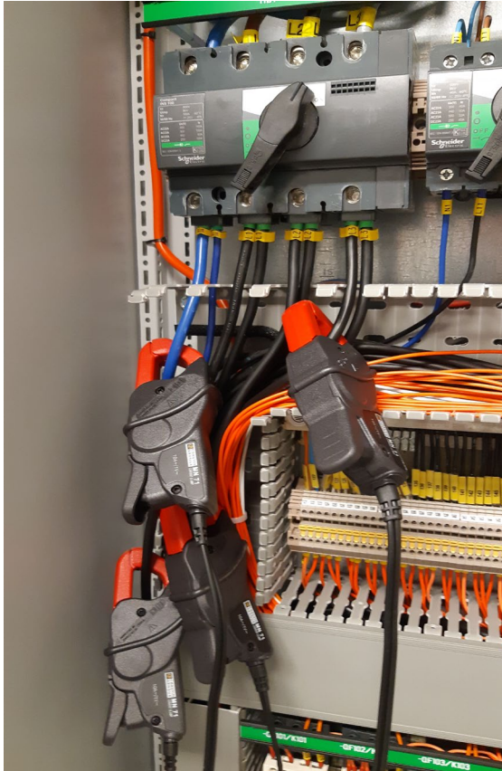
Figur 3.4. Uppkoppling av SPQfx genom strömtänger.
